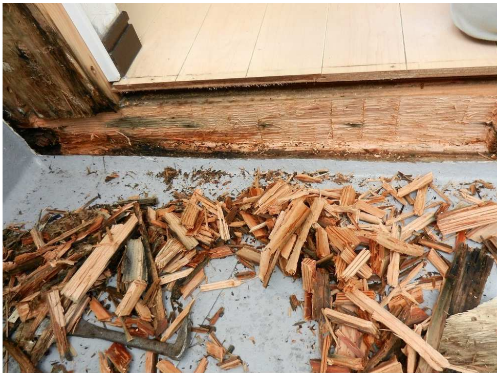
ベランダ大梁腐食部撤去
